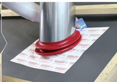
Povrch musí být suchý, stabilní a zbavený prachu, nečistot a separačních prostředků. Je třeba se vyvarovat záhymů a skladů. Průměr manžety musí být odpovídající průměru pláště komína. Není určeno na savé a porézní materiály jako beton, omítka, dřevovláknité desky apod. V případě pochybností proveďte test lepidla. Vnitřní plocha manžety je z výroby potažena maskem. Pokud je mazný efekt nedostatečný, použijte silikonový sprej.
