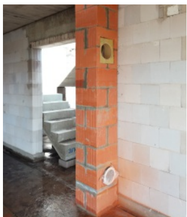
Príprava na prívod vzduchu z boku
