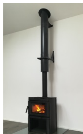
Lakováný zvislý dymovod s funkciou komína
