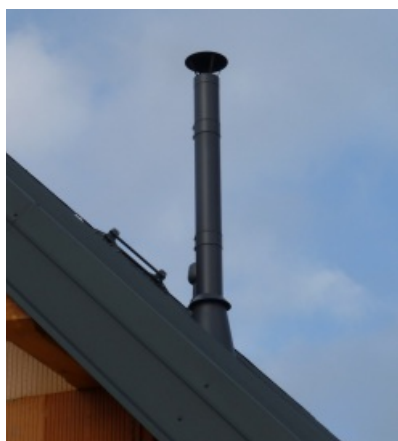
Nerezový komín lakovaný podľa odtieňa krytiny
