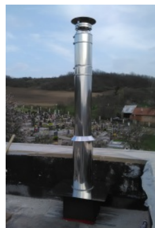
Prestup a vysoké lemovanie na plochej streche
