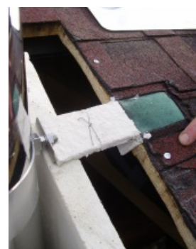
Priklad uchycenia strešného držáka
