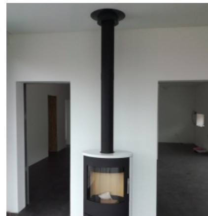
Lakový zvislý dymovod s funkciou komína
