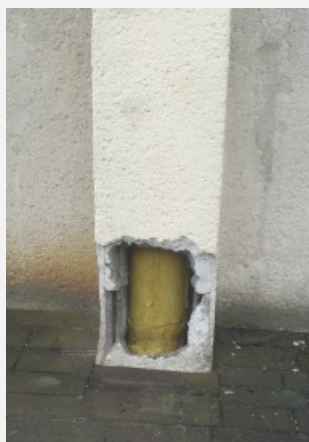
Z realizace vložkování SANATEC s izolací
