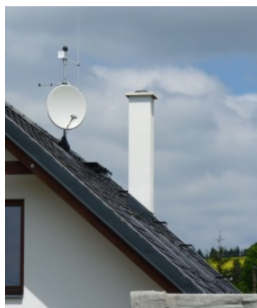
Omietnutá základná nadstrešná časť
