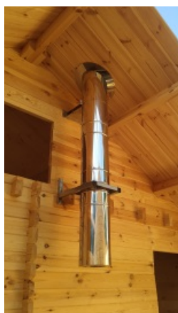
Príklad založenia zvislého dymovodu
