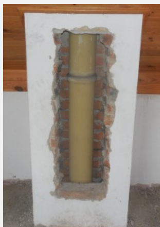
Z realizace vložkování SANATEC
