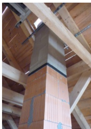
Prerušenie tepelného mostu v úrovni stropu
