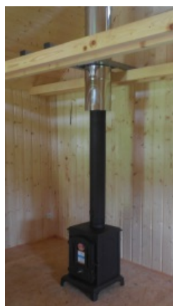
Zvislý dymovod s funkciou komína
