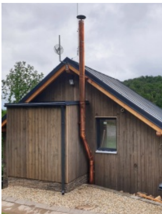
Galvanicky pomedžený fasádny nerezový komín
