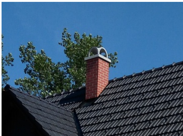
Realizácia s návlakom Imit a historickou hlavou
