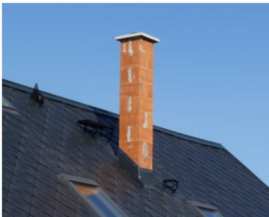
Základná nadstrešná časť pred finálnou úpravou
