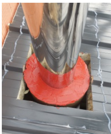
Parotesný prestup zatrený žiaruvzdorným silikónom
