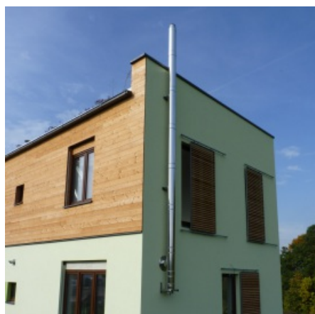
Fasádny nerezový komín na novostavbe
