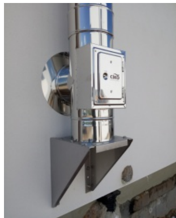
Fasádný komín na konzole s dvierkovým dielom
