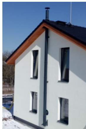
Lakovaný fasádny komín
