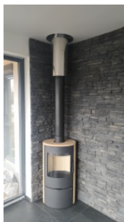
Zvislý dymovod s funkciou komína
