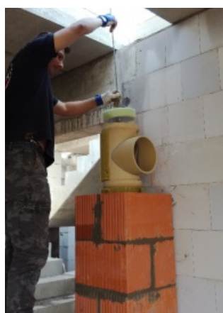
Čistenie spojov CIKO TEC
