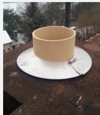
Ukončení nerezovým krycím límcem
