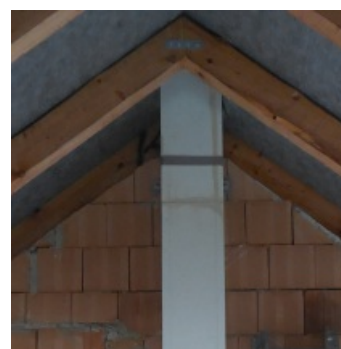
Priebežné kotvenie stenovým úchytom
