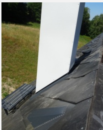
Detail přesazení návluku štuko přes lemování
