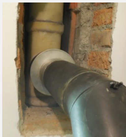
Napojení kouruvodu redukci na izostatické vložky
