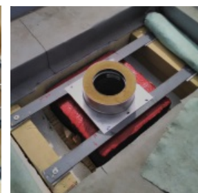
Detail založenia v plochej streche
