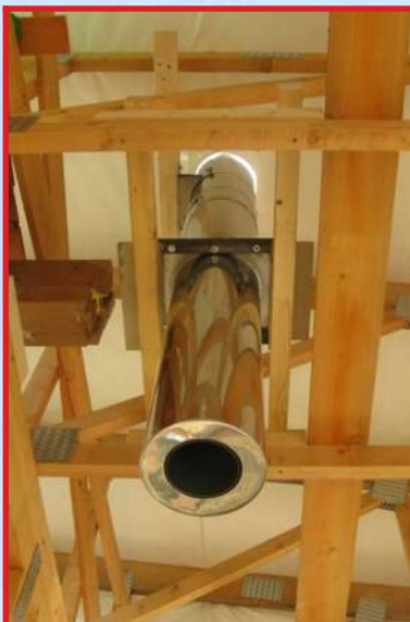
Ukázka založení přímého kouřovodu v dřevěné konstrukci
