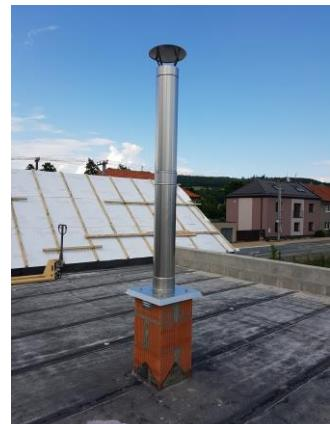
Podstřešní nástavec se v místě průchodu krovem kotví ke konstrukci krovu pomocí komínového držáku. Mezi komínovým držákem a hořlavou konstrukcí krovu musí být umístěna **nehořlavá podložka** (např. z materiálu SILCA tl. 50 mm). Volné vyložení komína nad držákem je max. 3 m.
